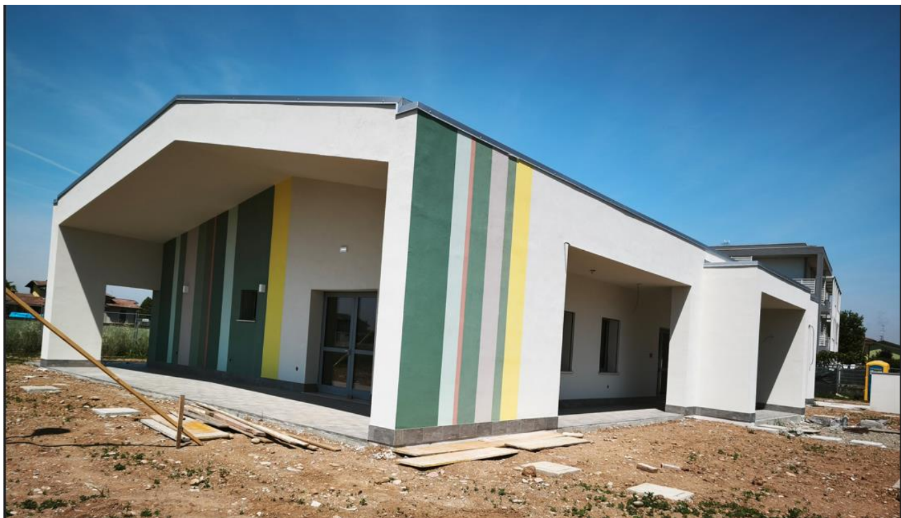
Foto 1: vista lato sud-est da via Don Lino Toninelli
